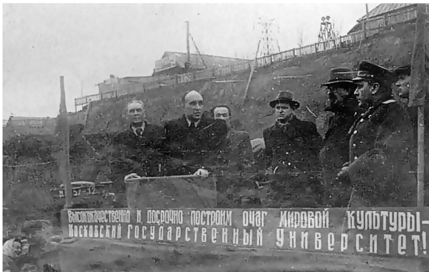
Первый кирпич в фундамент ГЗ был заложен 12 апреля 1949 года
