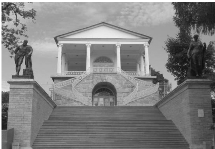
Вход в галерею со стороны парка открывают Геракл и Флора
