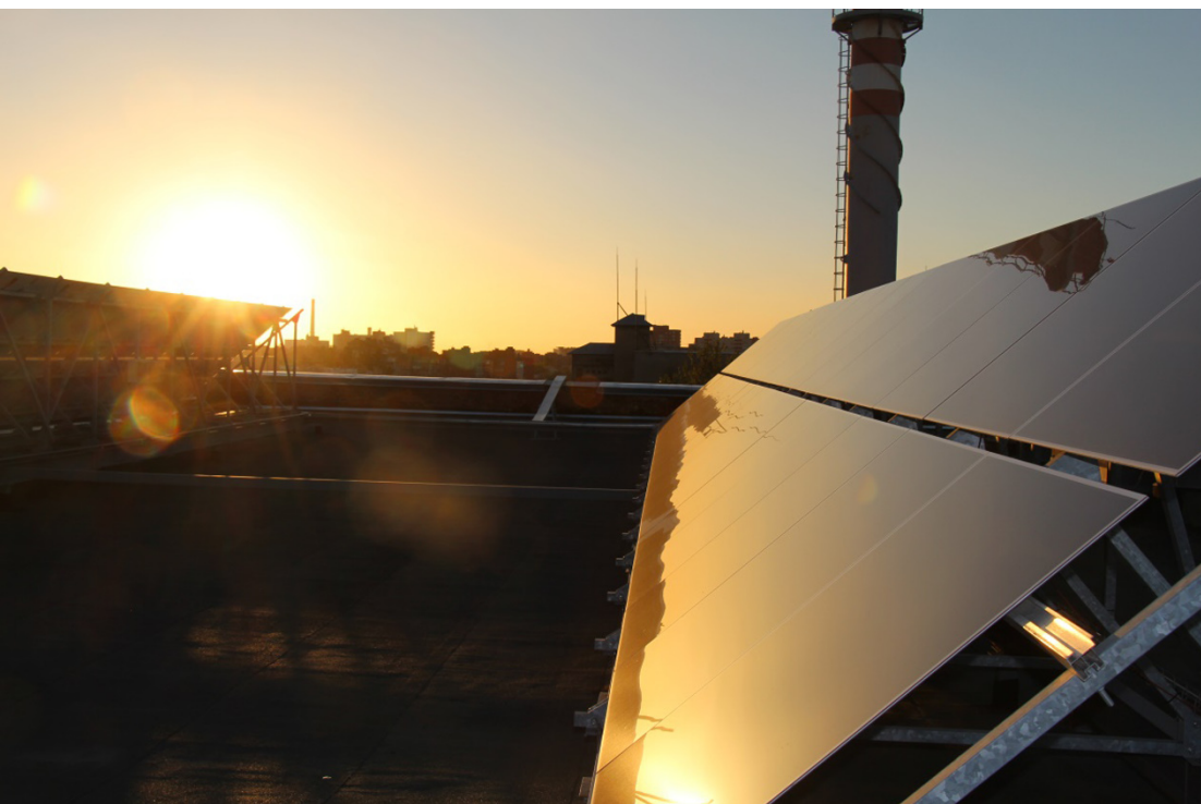
Рисунок 2. Солнечный модуль на основе аморфного кремния на крыше здания в г. Санкт-Петербург
