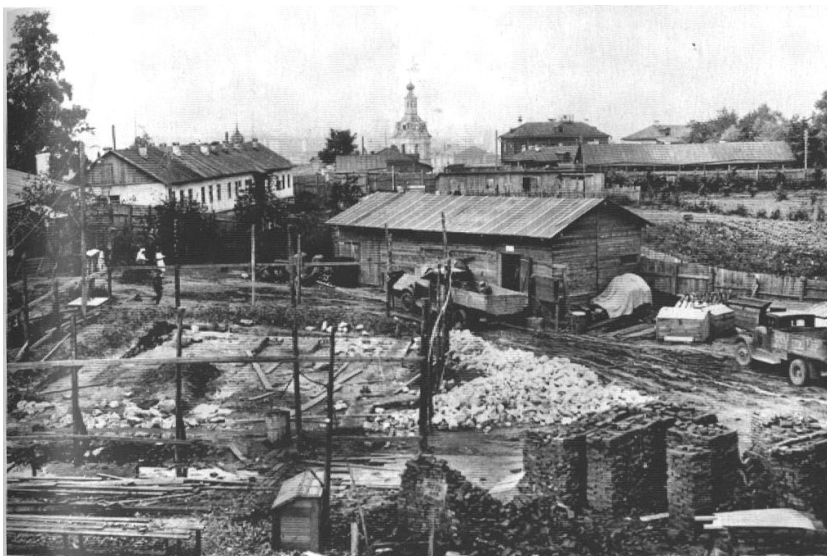
Строительство ИФП на Калужском ш. 32, осень 1935 г.
